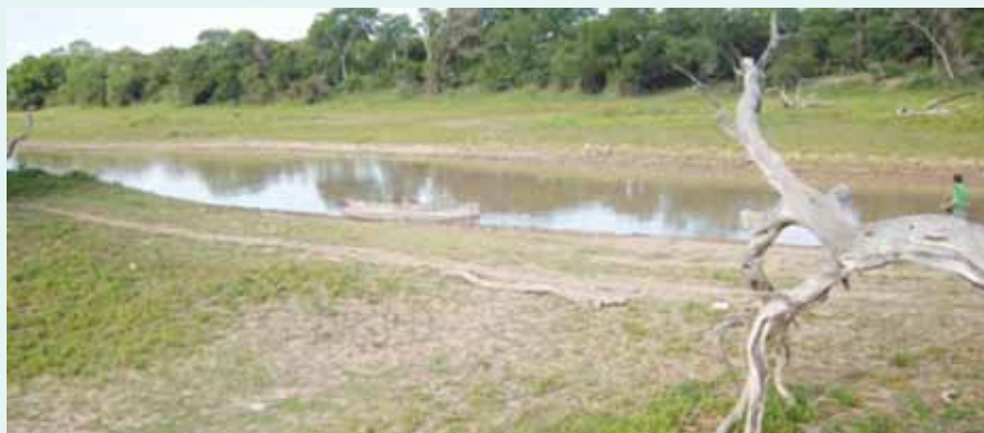
Obra de ingreso sistema de lagunas – Zona de Obras
