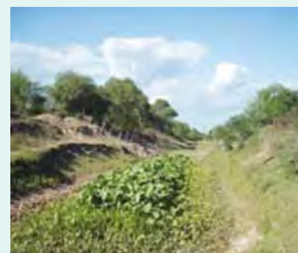
Canal de descarga
