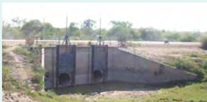
Reacondicionamiento de Obra de Compuertas en Ruta 3
