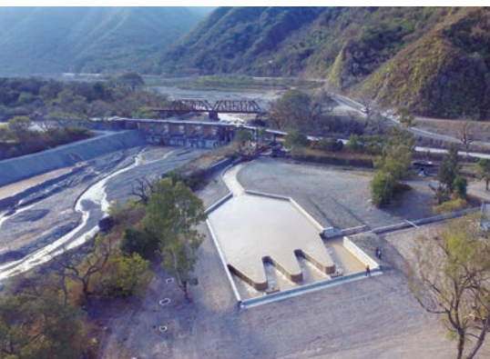
Vista aérea del desarenador en la zona de captación del sistema de riego (río Toro, Salta)
