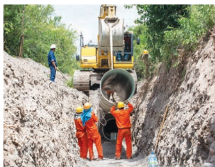
Instalación de caños de PRFV para conducto presurizado (obra río Toro)
