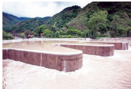
Desarenador en zona de captación" (río Toro, Salta)
